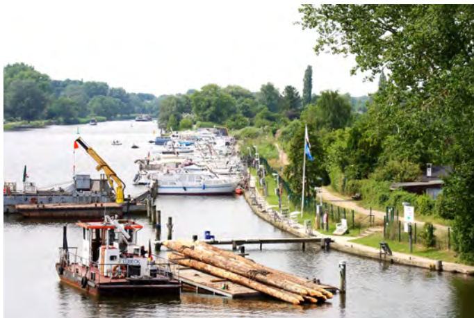
Die Baustelle ist eingerichtet, die neuen Dalben liegen bereit.
